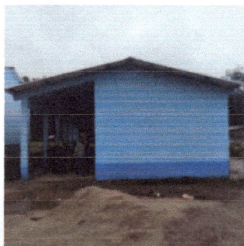
Foto 3: Vista Lateral paredes remozadas.
