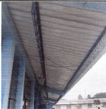
Foto1: Mantenimiento de Cubierta de lamina, aplicación de pintura.
