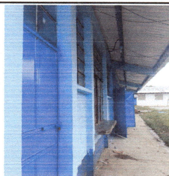
Foto 2: Vista puertas remozadas.
