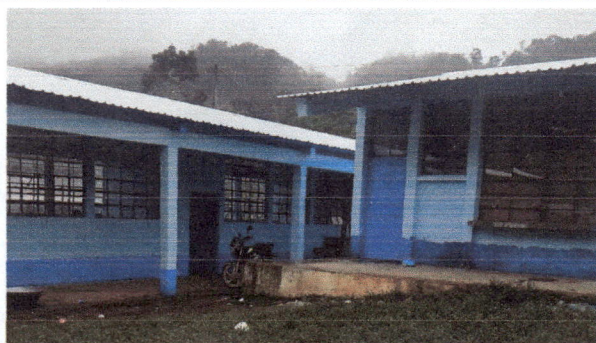
Foto 5: Vista panoramica paredes exteriores remozadas.
