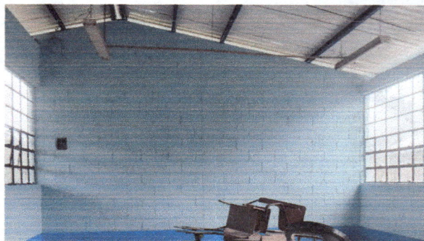
Foto 4: Vista Interior de aulas.
