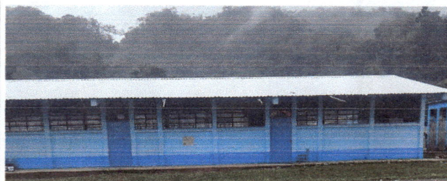
Foto 6: Vista panoramica cubierta de establecimiento remozada.
